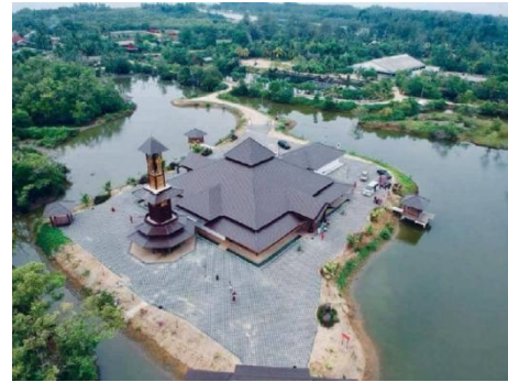
Figure 11. Sungai Pengkalan Datu Source: Arkitek Punca Cipta [15]
