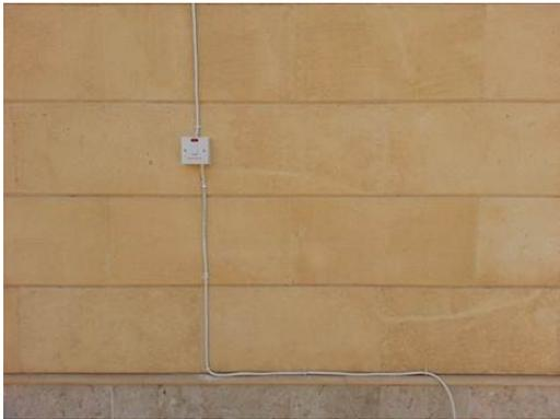
شكل ٤. الإضاءة: تمديدات إضافية للكهرباء لعناصر أضيفت لاحقاً (الباحث).
