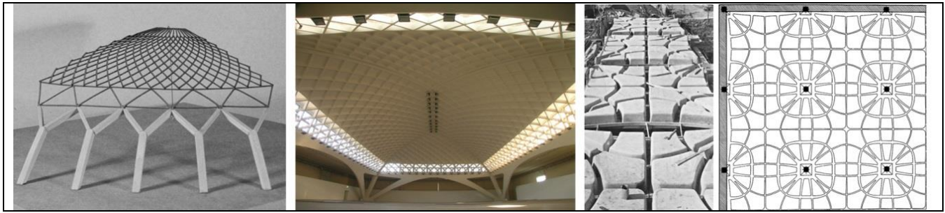
المصدر: http://anengineersaspect.blogspot.com.eg/2009/10/22-pier-luigi-nervi-structures-on.html شكل (10) أعمال المعماري الإيطالي نيرفي في العمارة الحديثة
