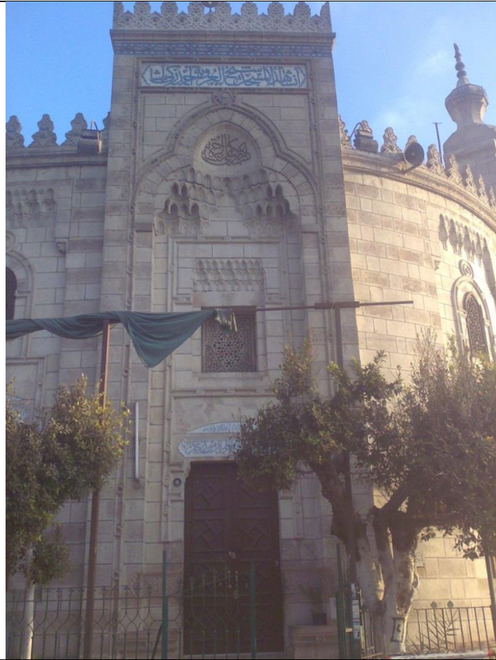
صورة رقم ٣: المدخل التذكاري الرئيسي للمسجد بالجهة الجنوبية.
