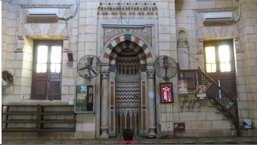
صورة رقم ٢٤: الجهة القبليّة ويظهر بها المنبر والمحراب والنافذتين على جانبي المحراب.
